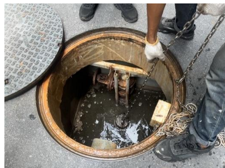
รูปที่ 2-36 เครื่องสูบน้ำในบ่อหน้าวงน้ำ
