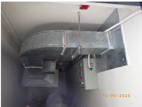
รูปที่ 2-18 ระบบระบายอากาศภายในห้องพักมูลฝอย
