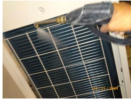
รูปที่ 2-38 การล้างแผ่นกรองอากาศของ เครื่องปรับอากาศ
