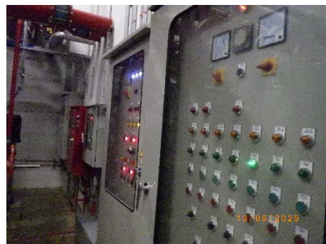
รูปที่ 2-19 ระบบมิเตอร์ไฟฟ้าสำหรับระบบบำบัดน้ำเสียของโครงการ
