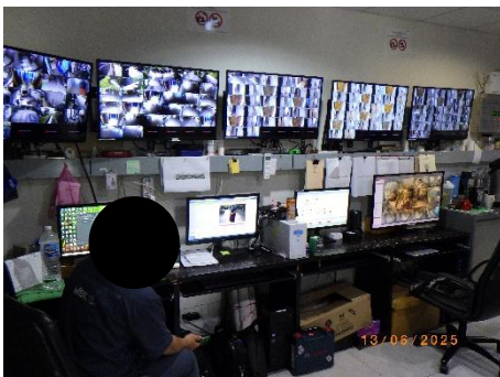
รูปที่ 2-65 ระบบโทรทัศน์วงจรปิด (CCTV System)
