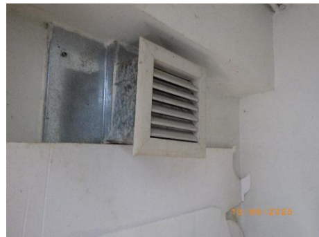
รูปที่ 2-18 ระบบระบายอากาศภายในห้องพักมูลฝอย
