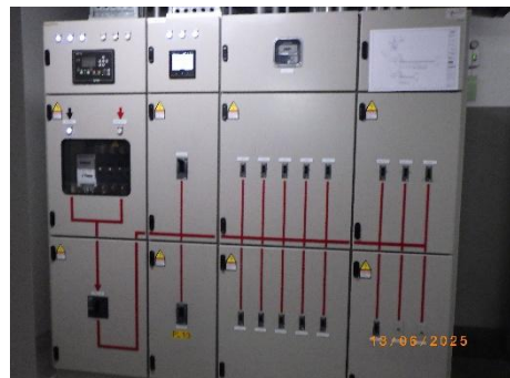
รูปที่ 2-19 ระบบมิเตอร์ไฟฟ้าสำหรับระบบบำบัดน้ำเสียของโครงการ
